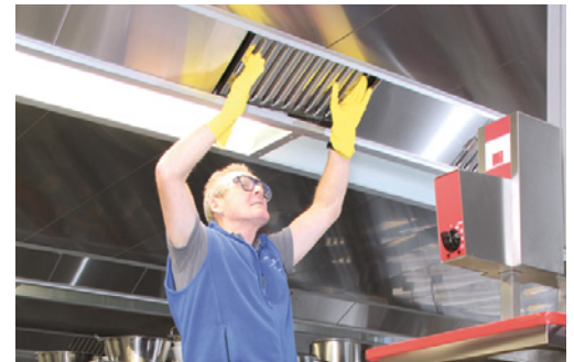
Figura 6: eseguire i lavori di pulizia con appositi dispositivi di protezione
