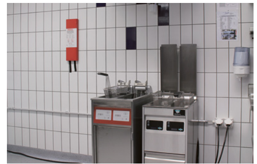
Figura 5: tenere una coperta antincendio a portata di mano vicino alla friggitrice
