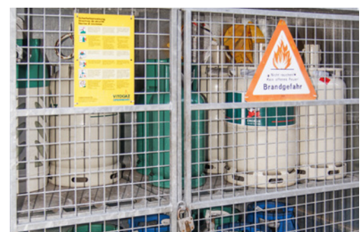
Figura 8: bombole di gas stoccate in modo corretto
